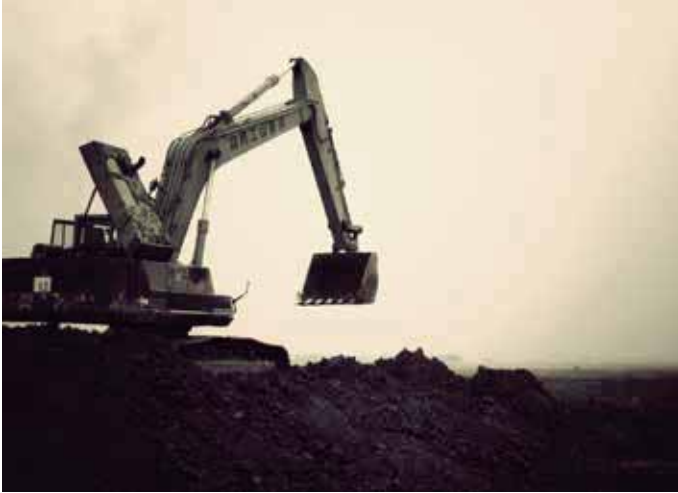
Những ngày đầu khởi công dự án
