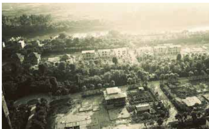
Những công trường bê bộn
